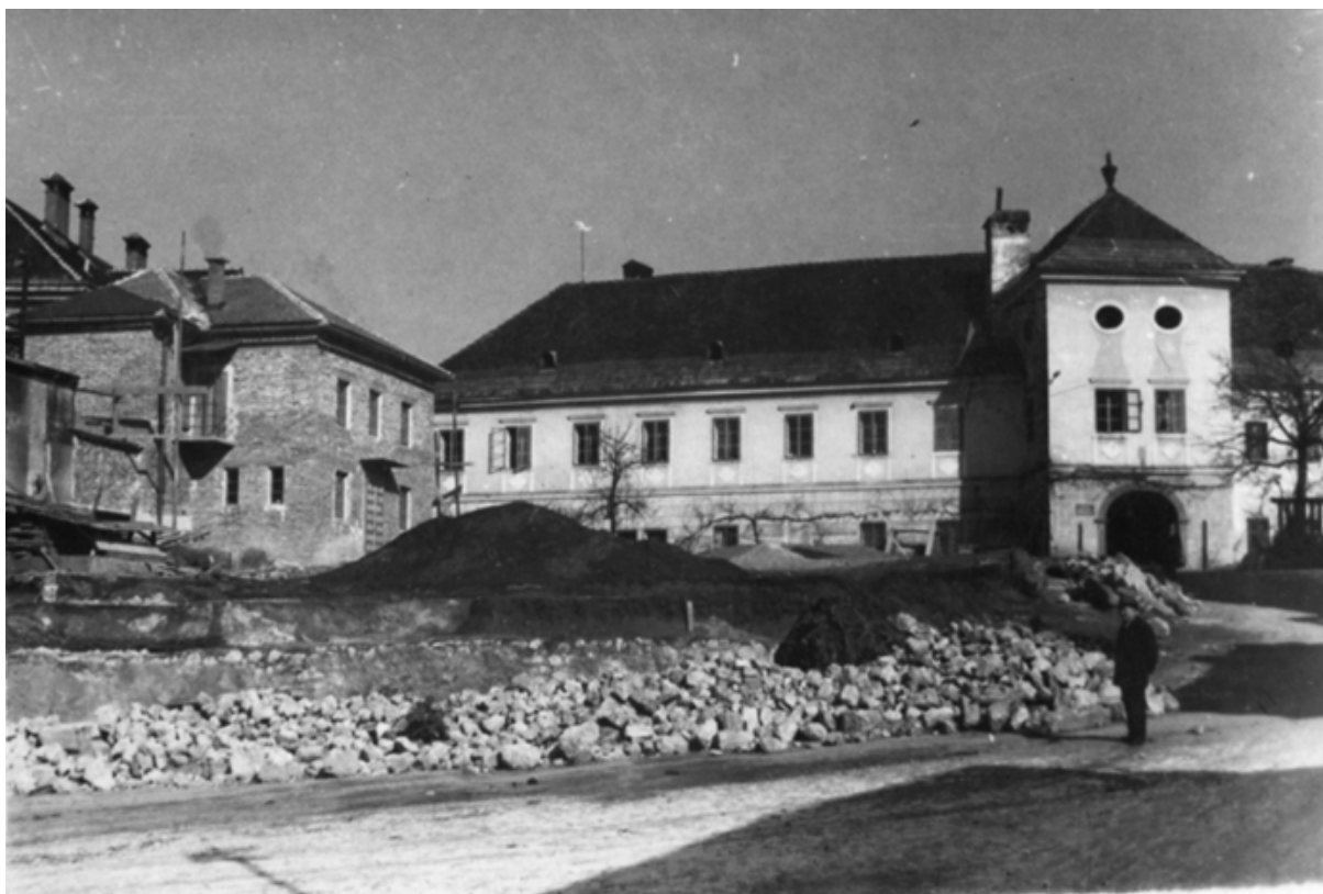
Leta 1953 so grajski vrt porušili in na tem mestu pričeli graditi terase za potrebe izgradnje osrednjega metliškega spominskega parka NOB. Belokranjski muzej Metlika.
